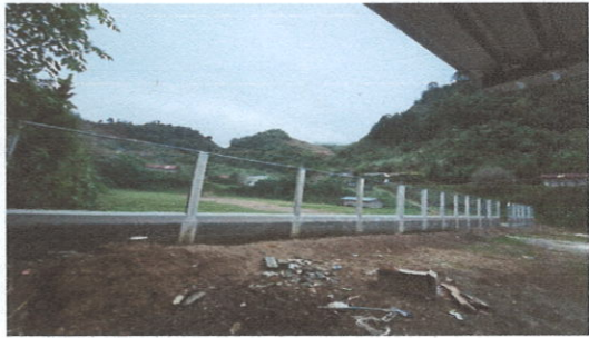
Foto1: Muro perimetral fízalizado
