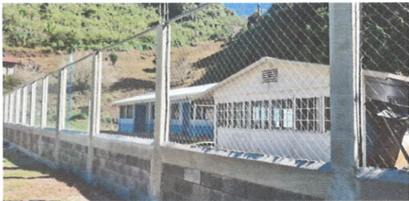
Foto 3: Insrlatación de maya fízalizado
