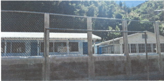
Foto 4: El perímetro ya se encuentra en perfectas condiciones y finalizado
