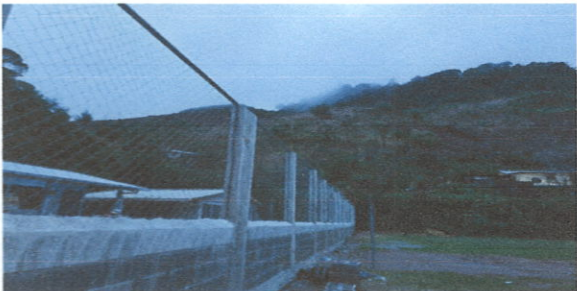
Foto 5: Las columnas ya estan en perfectas condiciones fízalizado
