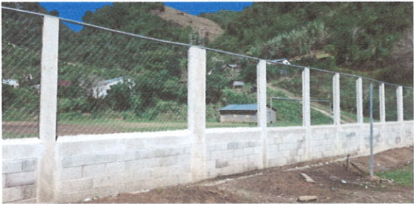
Foto 6: El muro perimetral ya es adecuado para las instalaciones y finalizado
