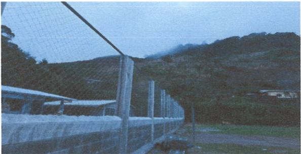
Foto 2: Mejoramiento de las columnas ya finalizado
